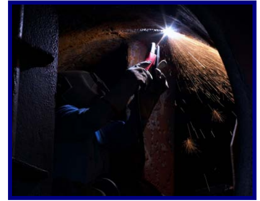
Arc Gouging ( High )
