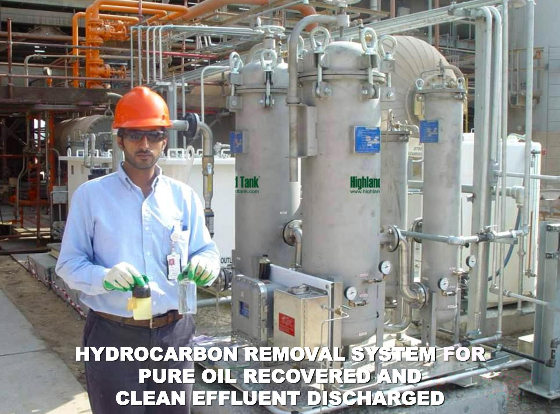
**HYDROCARBON REMOVAL SYSTEM FOR
